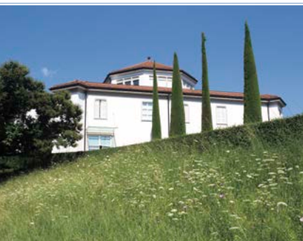
Prato estensivo davanti alla facciata ovest del museo.
